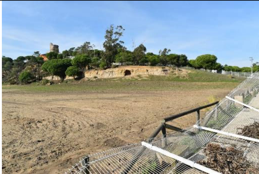
Imágenes de la Torre del Catalán y su falta de accesibilidad
