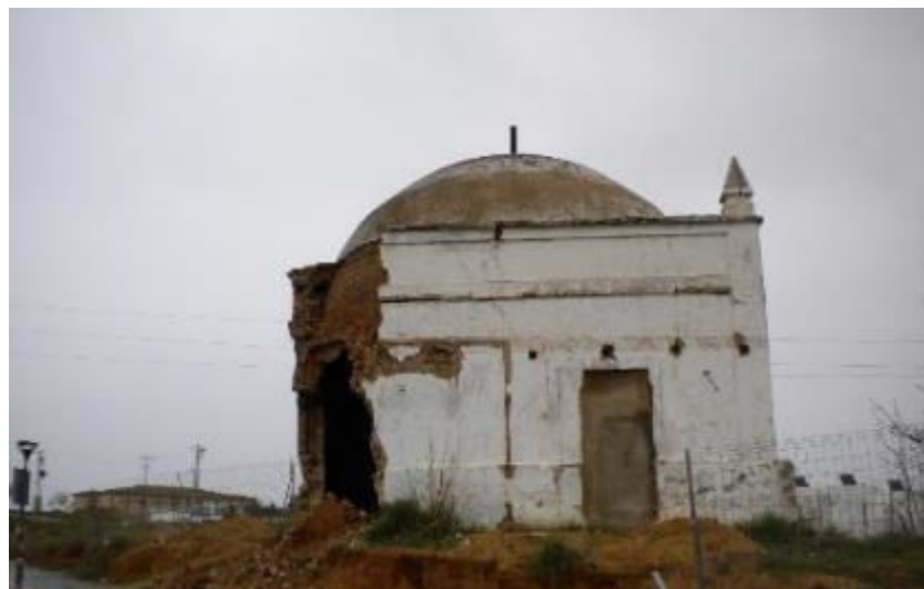
Detalle del derrumbe parcial del inmueble.
