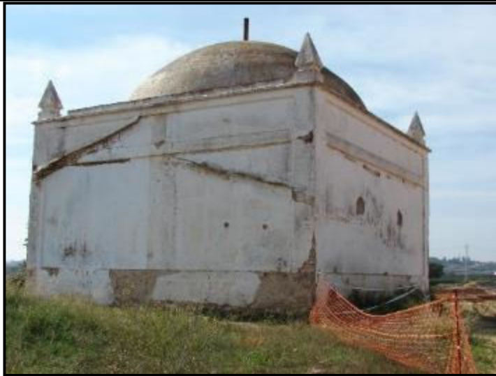
Detalle de uno de los laterales en el que puede observarse los restos de la techumbre de un edificio adosado con posterioridad a la construcción original.
