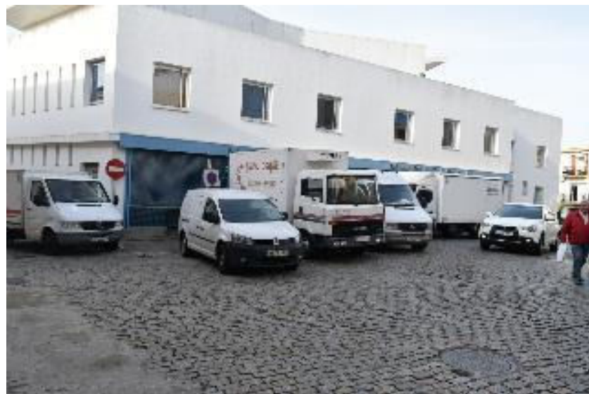
Colapso diario en actual plaza de abastos en pleno centro urbano
